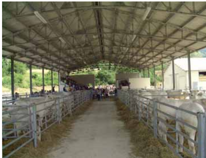
Panoramica delle strutture del Centro Manze di Ponte Presale
